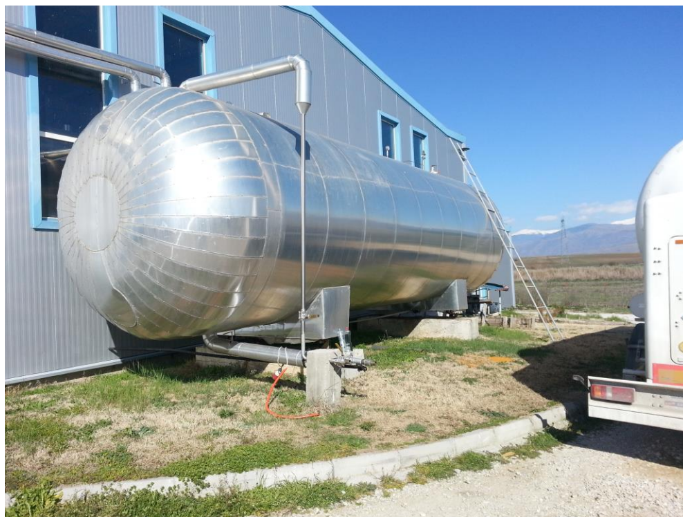
Слика бр.29 Скалдирање на течен \text{CO}_2 (цистерна од 50 t)
