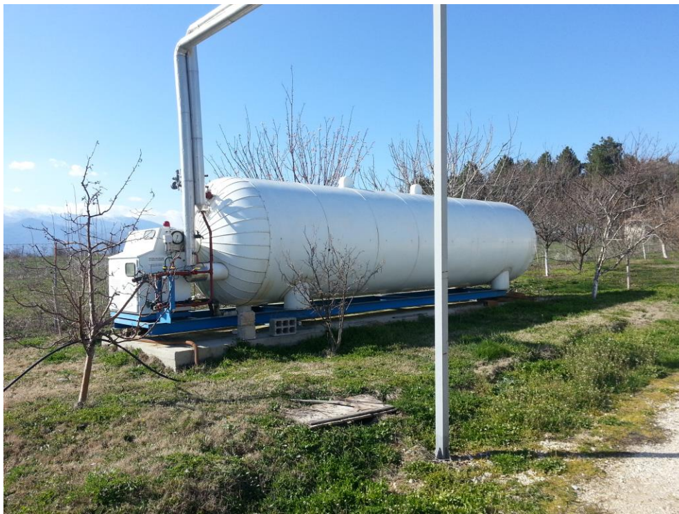
Слика бр.30 Скалдирање на течен CO 2 (цистерна од 20 t)
