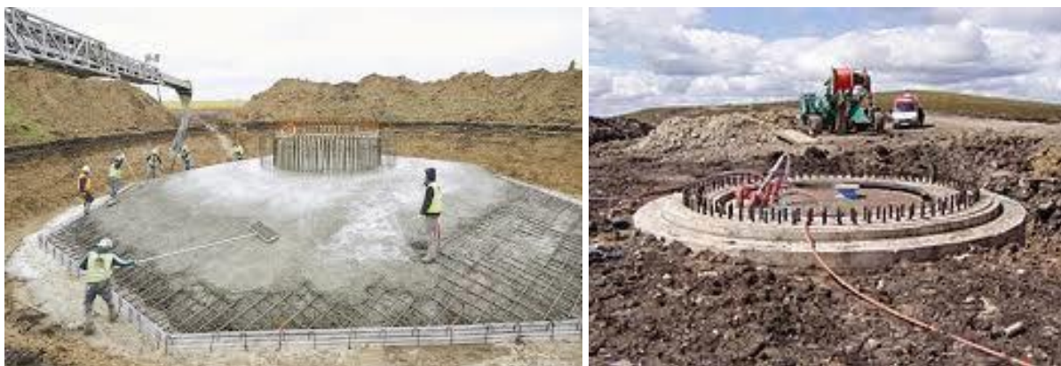
Слика 28 Конструкција на темел за ветерна турбина (извор: Google)
