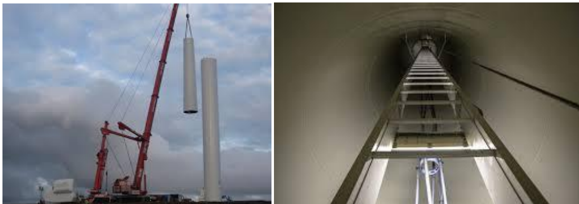
Слика 17 Монтажа на носечки столб и внатрешност на столб на ветерна турбина (Извор: Google)
