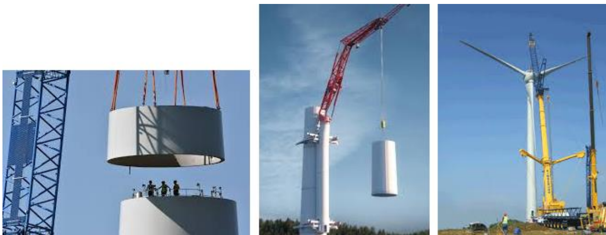
Слика 122 Конструкција на ветерна турбина со користење на кран (Извор:Google)
