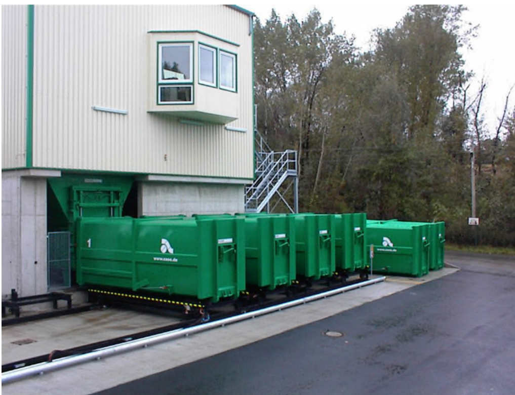
Слика 15 Целосно затворена претоварна станица со постројка за преместување
