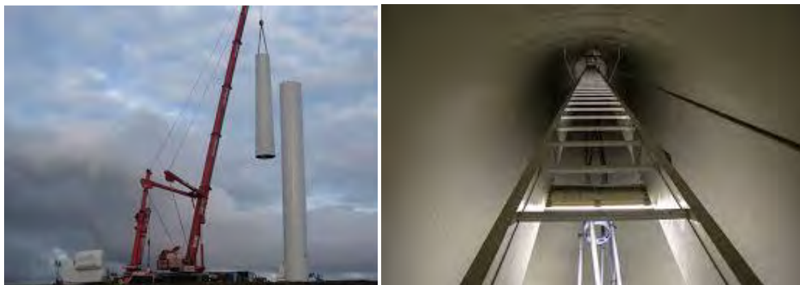
Слика 15 Монтажа на носечки столб и внатрешност на столб на ветерна турбина (Извор: Google)
