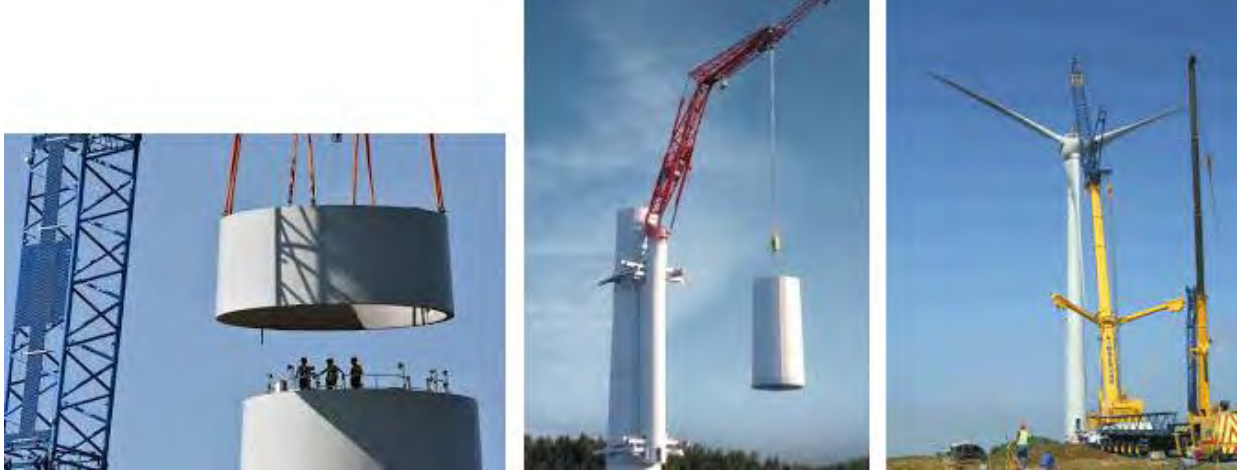
Слика 108 Конструкција на ветерна турбина со користење на кран (Извор:Google)
