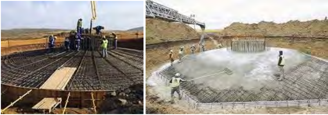
Слика 23 Конструкција на темел за ветерна турбина (извор: Google)
