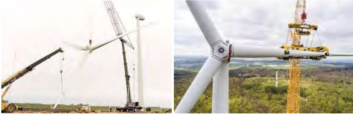
Слика 25 Монтажа на опрема (извор: Google)
