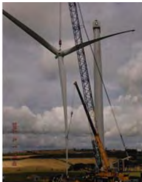
Слика 77 Конструкција на ветерна турбина со помош на кран (Извор: Google)
