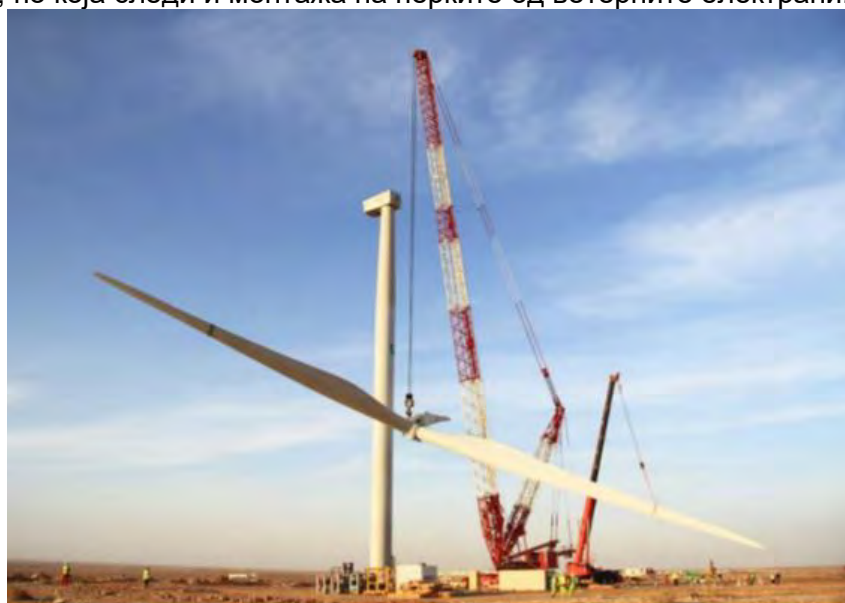
Слика 10 Монтажа на опрема (извор: Google)
