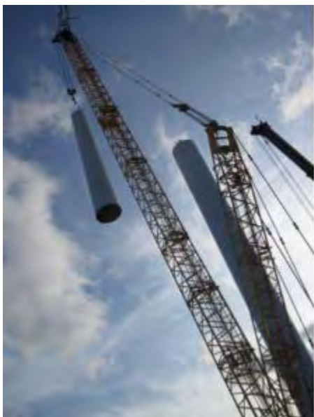
Слика 77 Конструкција на ветерна турбина со помош на кран (Извор: Google)
