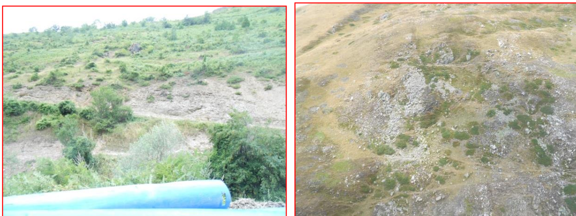
Слика 13 Процеси на површинска ерозија а) околина на Бозовце б) П.Шапка, Фото: И.Блинков
