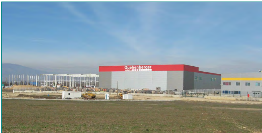
Слика бр.5-16: Објекти во индустриска зона Ќојлија
