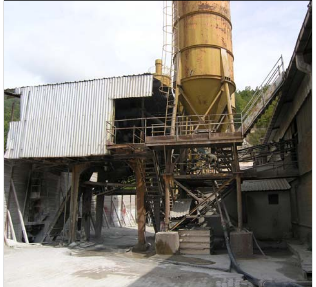
Сл.бр.12 Бетоњерка за основна бетонска маса
