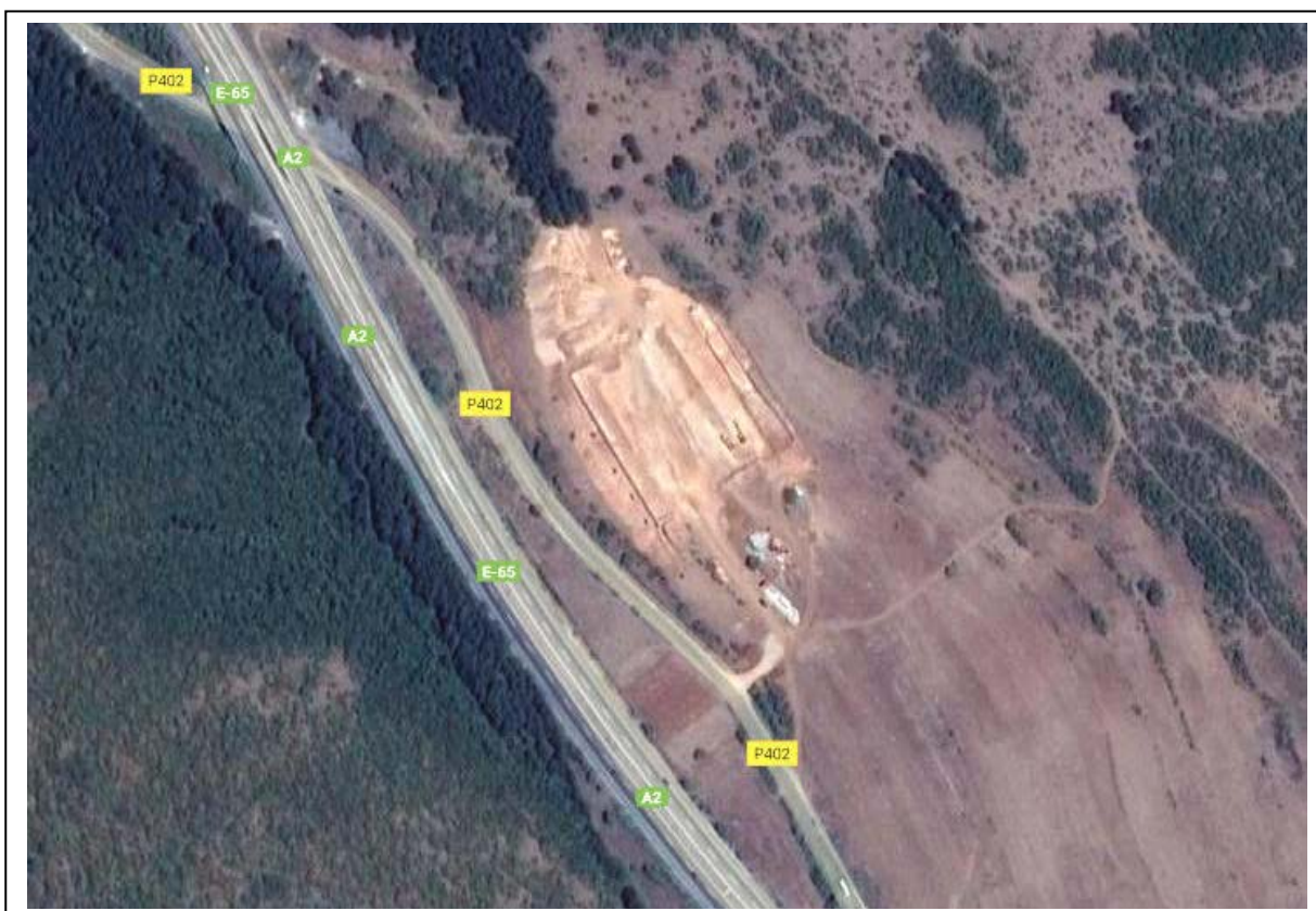
Слика II.1-1: Локација на објектот
