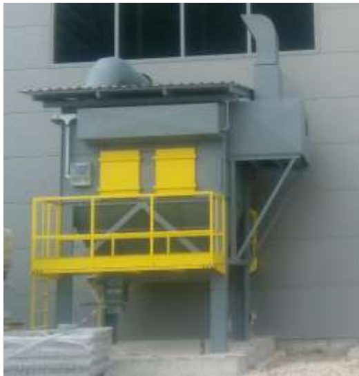
Слика 11 Систем за отпашување на песара (типот на CDR-20)
