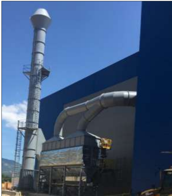
Слика 6 Филтер станица со оцак од погонот за припрема на песок и калаперска мешавина
