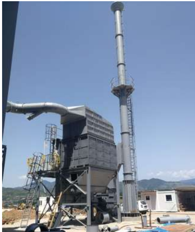
Слика 5 Филтер за електро-индукционите печки
