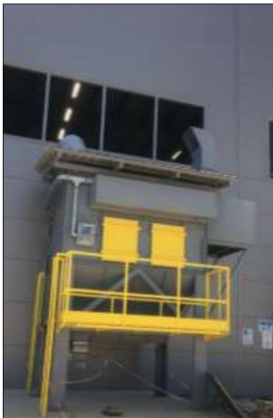
Слика 9 Филтер станица за пескара
