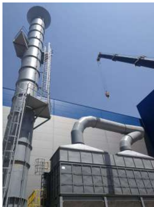
Слика 8 Системот за филтрирање на воздухот од погонот за подготовка на калаперска мешавина и истресувалка
