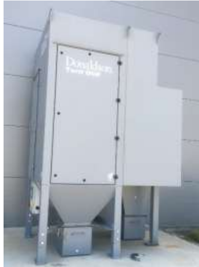
Слика 15 Систем за филтрирање на воздух Donaldson Torit, модел Cyclorpeel DFPRO 8
