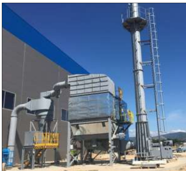
Слика 8 Филтер станица за печки и оџак
