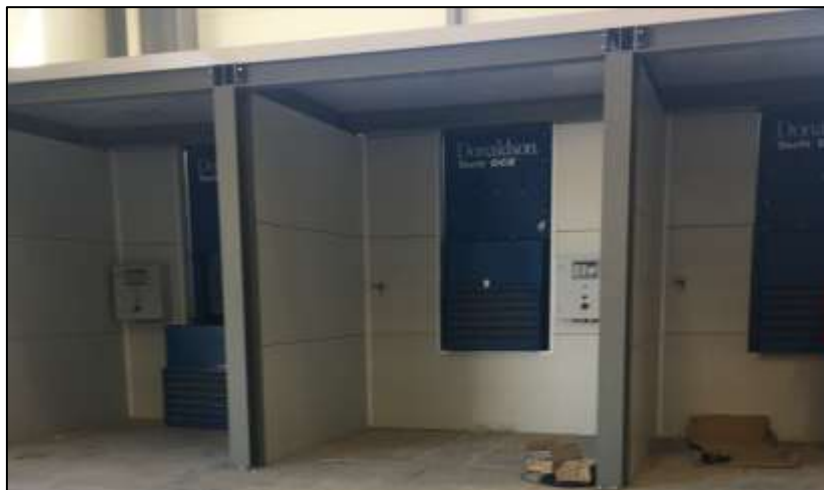
Слика 18 Систем за отпрашување (ECB Power Module)
