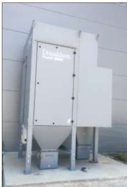
Слика 10 Филтер станица од завршно одделение
