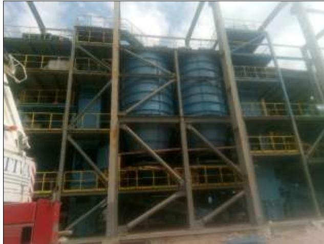
Слика 5 Силоси за складирање на песок и адитиви
