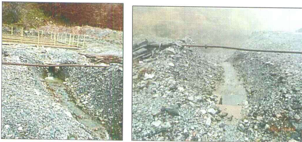
Слика 4 Таложник за јамска вода
