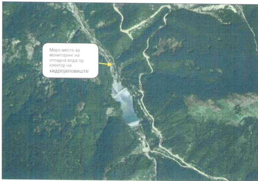
Слика 3. Мерно место отпадна вода од колектор на хидројаловиште
