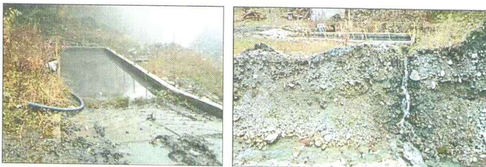
Слика 3 Таложник за јамска вода (поткоп II)
