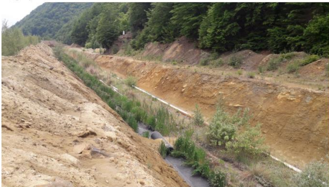
Сл. 1.1.5. Десен бок на таложно езеро 1, со пулповод и канал за одведување на вода од јамскиот коп, состојба на 31.5.2019
