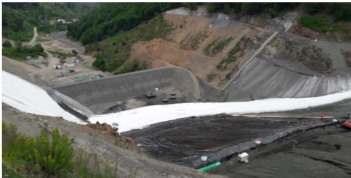
Сл. 1.1.1. Облагање на таложното езеро 4 и иницијална брана 4, состојба на 31.5.2019
