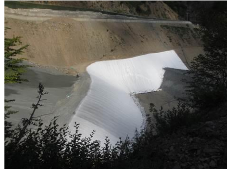
Градба на хидројаловиште бр.4 и поставување на геомембрана
