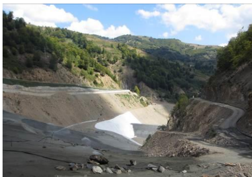
Градба на хидројаловиште бр.4 и поставување на геомембрана
