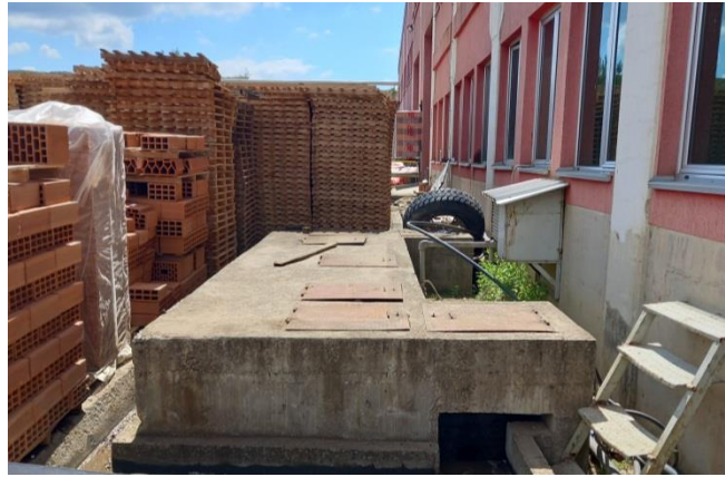
Слика 5 Септичка јама за отпадни санитарни води
