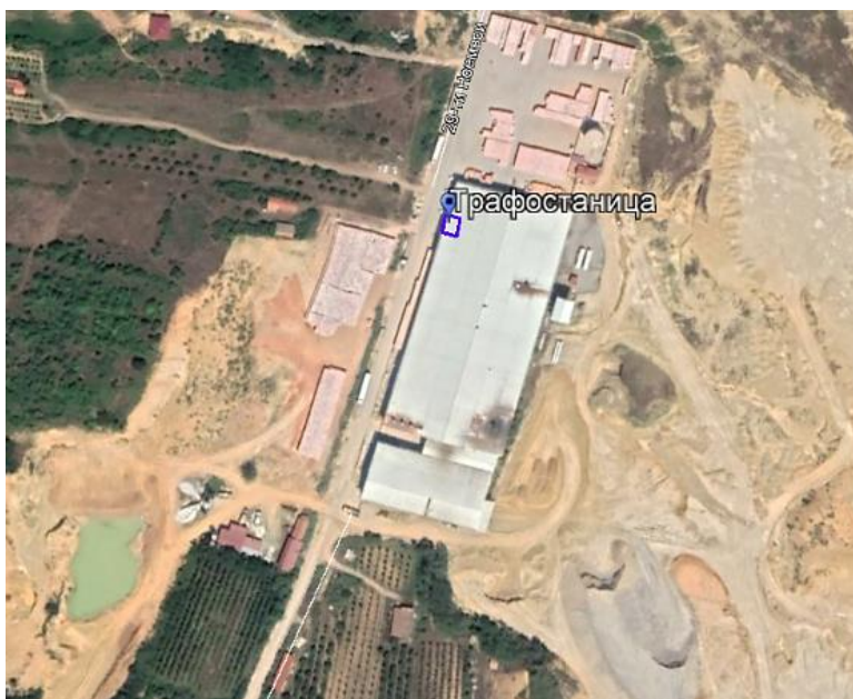
Слика 16 Локација на трафостаници, главен извор на нејонизирачко зрачење
