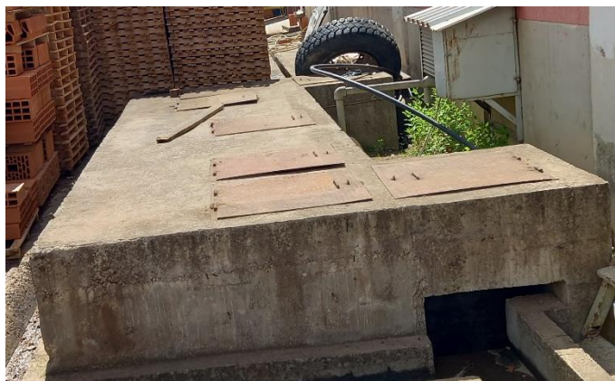
Слика 58 Септичка јама/шахта
