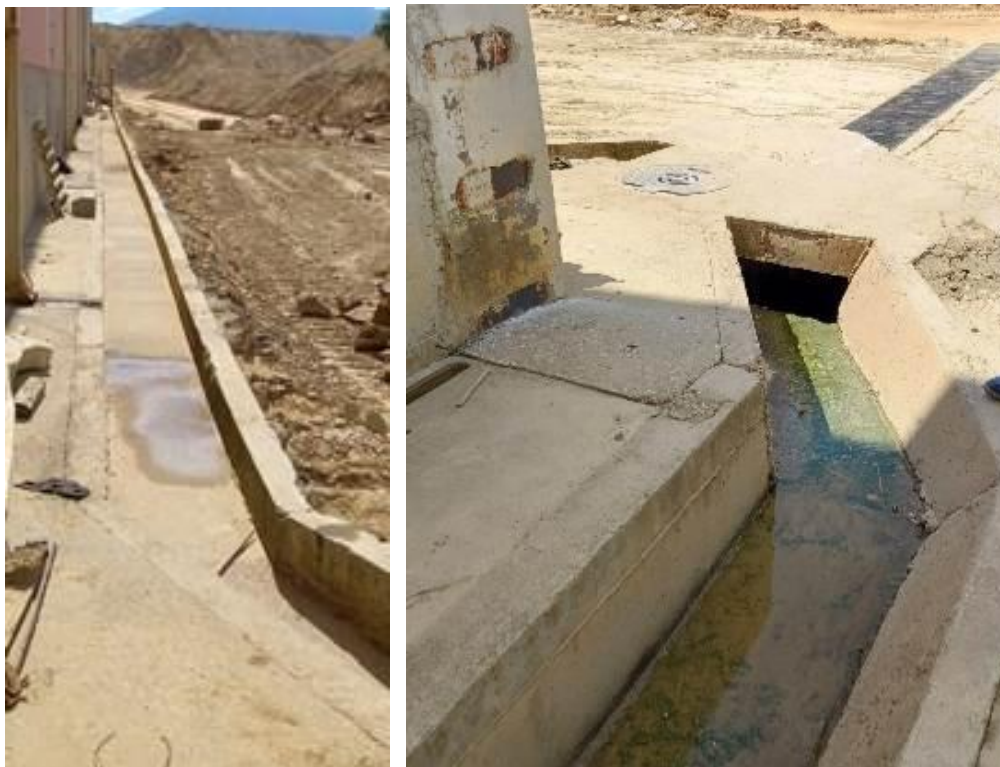
Слика 38 Собирен канал и таложник
