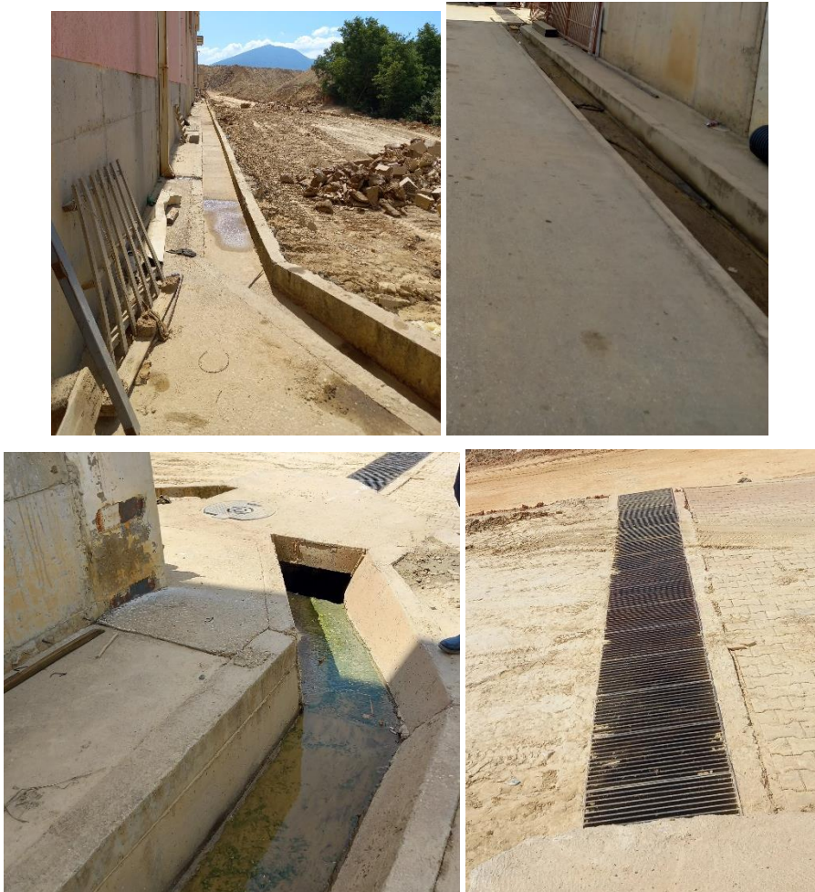
Слика 3 Атмосферски канали и таложник
