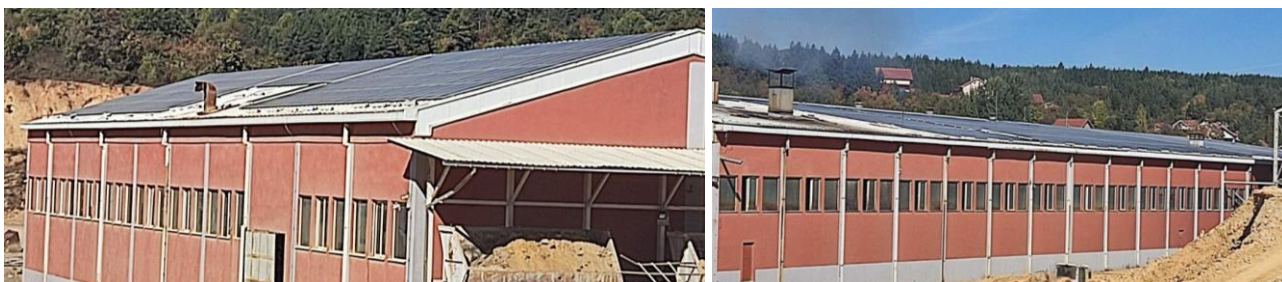
Слика 40 Фотонапонски панели поставени на кровна површина
