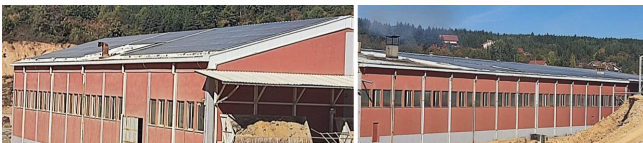
Слика 22 Фотонапонски панели поставени на кровна површина
