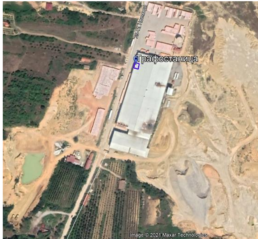
Слика 8 Локација на трафостаница, главен извор на нејонизирачко зрачење
