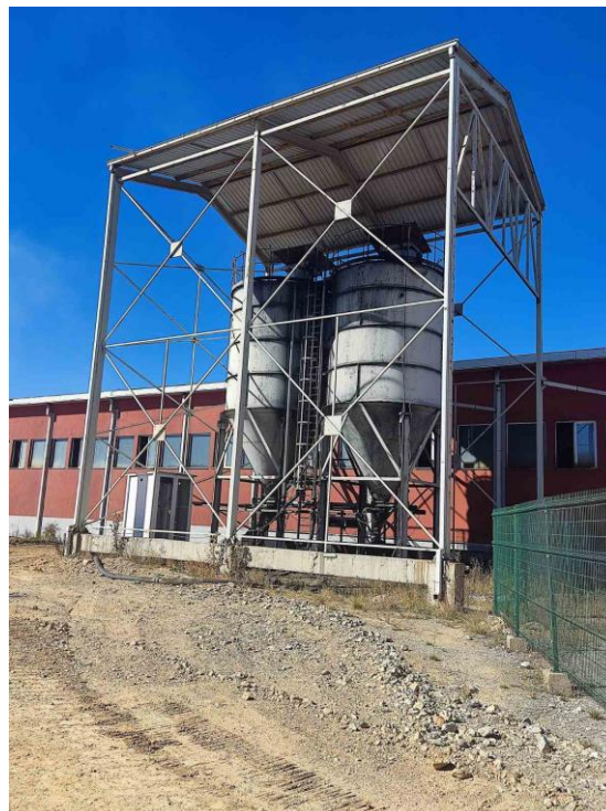
Слика 6 Вреќасти филтри на силоси за петролкокк
