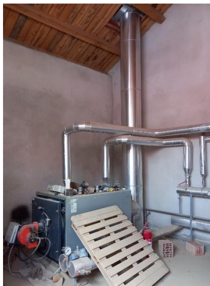
Слика 43 Топловоден котел тип БИАЗИ
