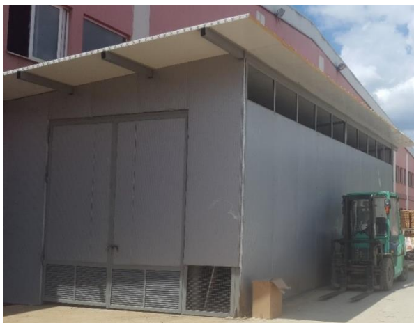
Слика 55 Компресорска станица
