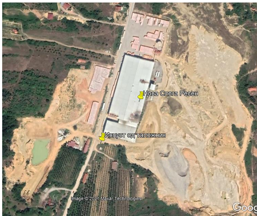
Слика 12 Локација на испуст на отпадни атмосферски води од површините и кровот на Инсталацијата и од миеше на тркала од возила (сателитска снимка од Google Earth)
