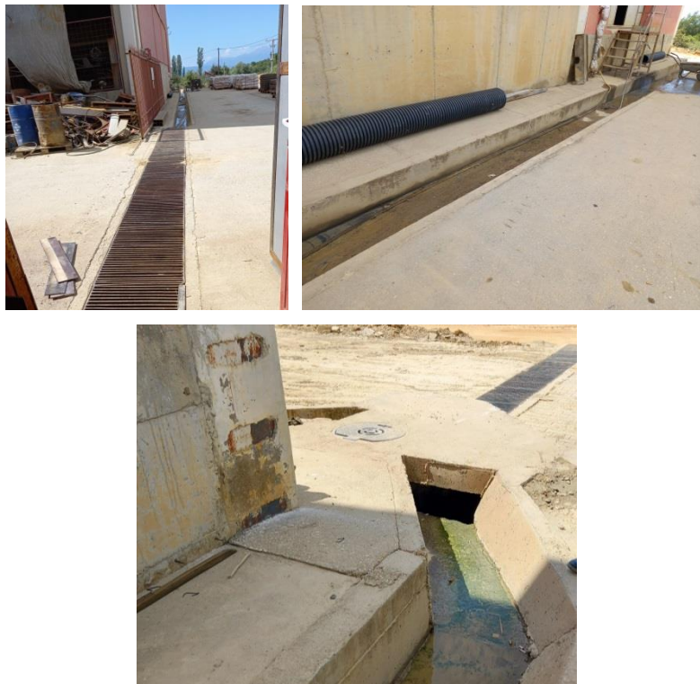
Слика 4 Таложник за отпадни атмосферски води и води од измивање на асфалтирана површина и тркала на камиони
