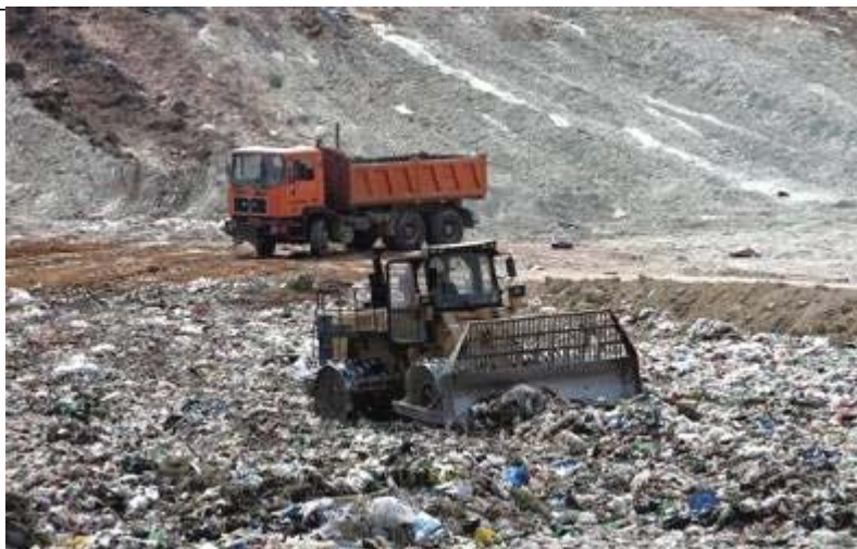
Слика бр. II-9: Планирање и набивање на отпадот
