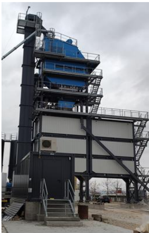
Елеватор, сито, бункери, контролна кабина - контејнер
