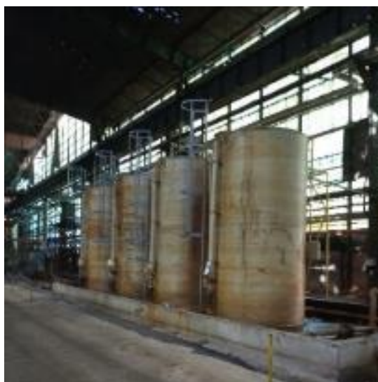
Слика бр. 12: Резервоари за отпадна киселина
