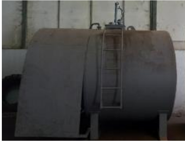
Слика бр. 37: Резервоар за нафта
