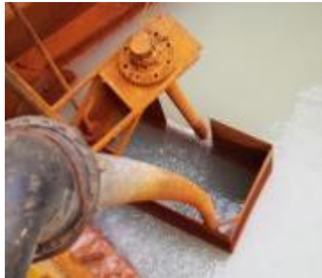
Слика бр. 34: Испусна шахта од базен бр. 4 и испусно место во канализација-AGW1
