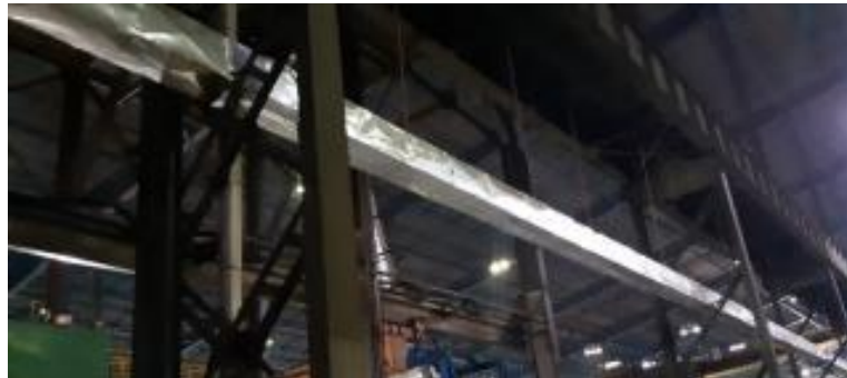
Слика бр. 18: Нов систем за искористување на топол воздух
