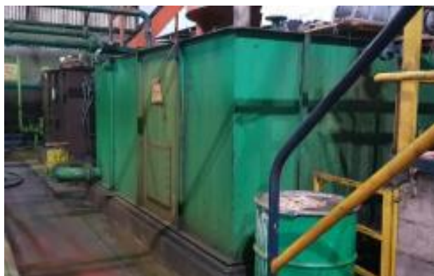
Слика бр. 26: Резервоар за подготовка на раствор од полимер
