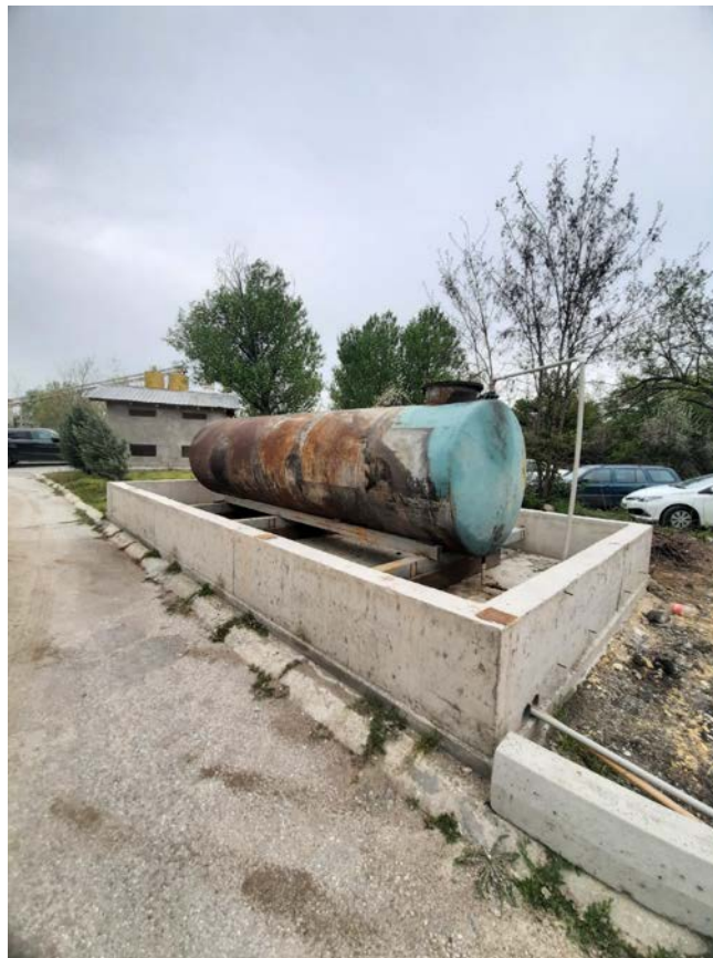
Слика бр. 10: Танквана за гориво
