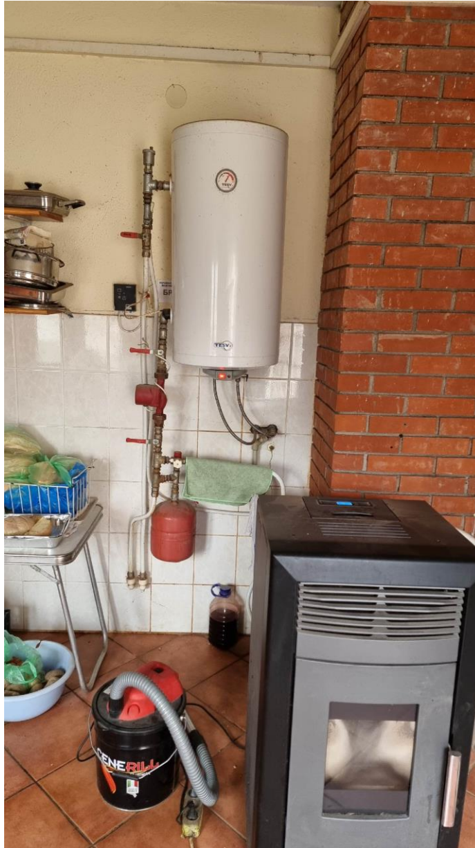
Котел за загревање на канцелариите 16 kW на Пелети
