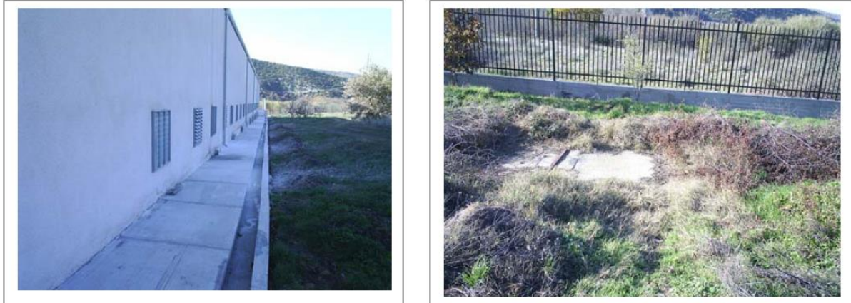
Слика VI.3-1 и VI.3-2: Бетонски канали и септичка јама
