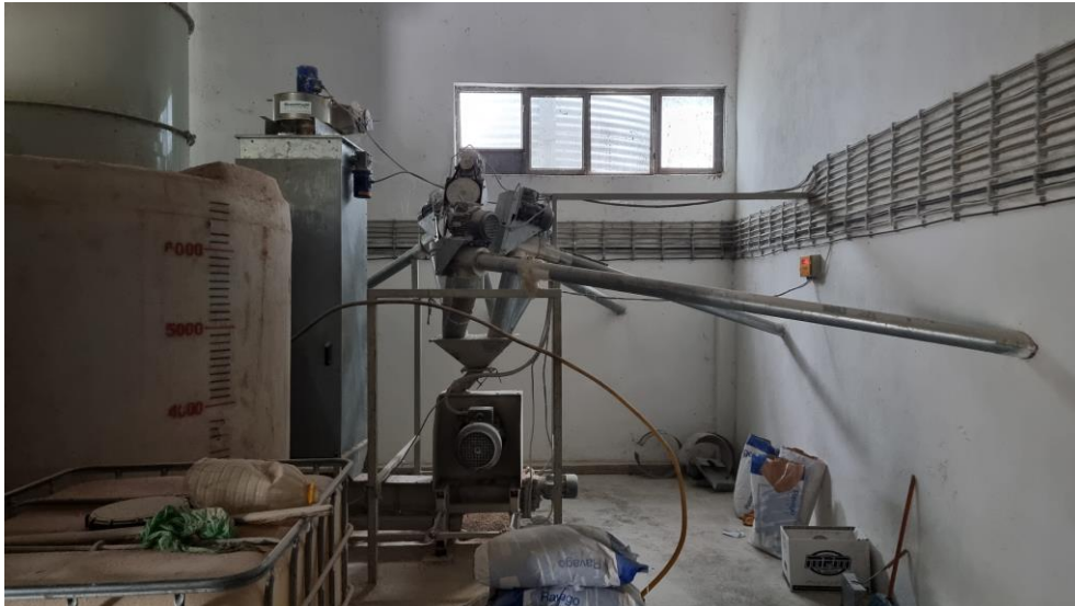
Слика II.3.1-2 и II.3.1-3: Силоси до млин и индивидуален силос до хала
