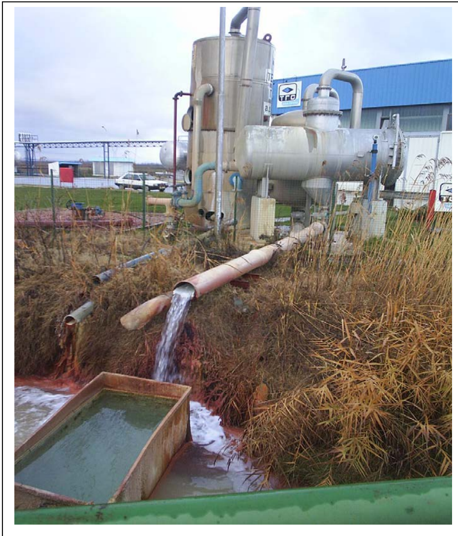
Слика бр. VI-3: Испуст SW 1
