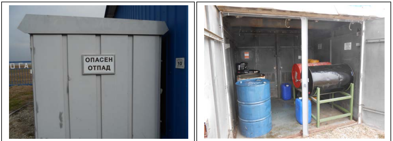
Слика бр. V-10 и V-11: Објект за одлагање на опасен отпад (употребено масло од компресорски единици) и внатрешен изглед на објект за одлагање на опасен отпад (употребено масло од компресорски единици)
