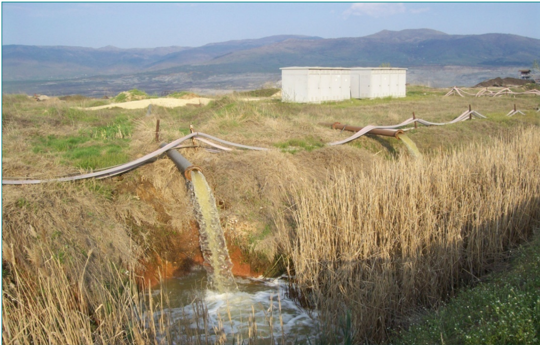
Слика бр.3-50: Ободен канал ОК-5 (Бошевски и др., 2009)
