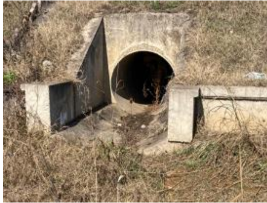
Слика 107: Изглед на насочник на цевест пропуст
