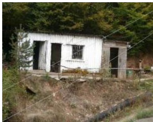
Слика 71 Објект за сместување на вработените
