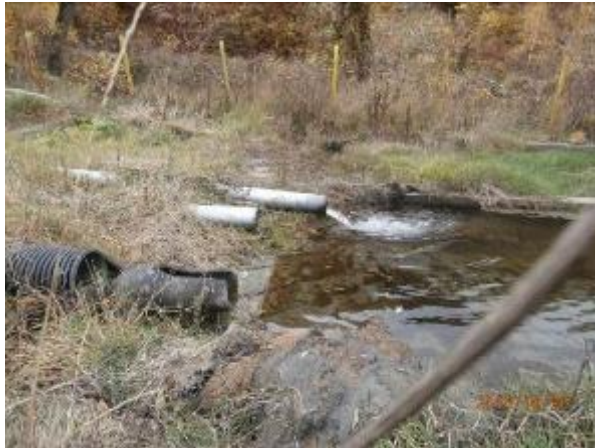
Слика 76 Бетонски и земјени таложници за собирање на пречистените води од хидројаловиштето
