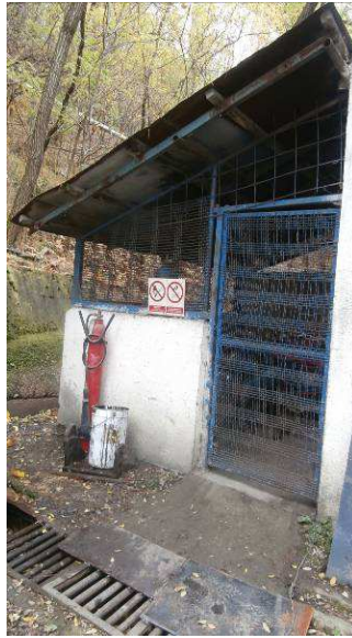
Слика 12 Простор за складирање на боци со ацетилен и кислород
