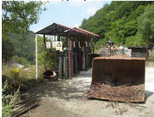
Слика 13 Простор за складирање на боци со ацетилен и кислород
