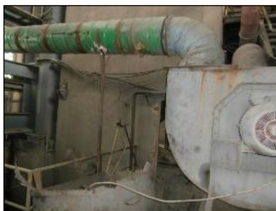
Слика 83 Системи за отпашување во погонот за дробење и сееење
