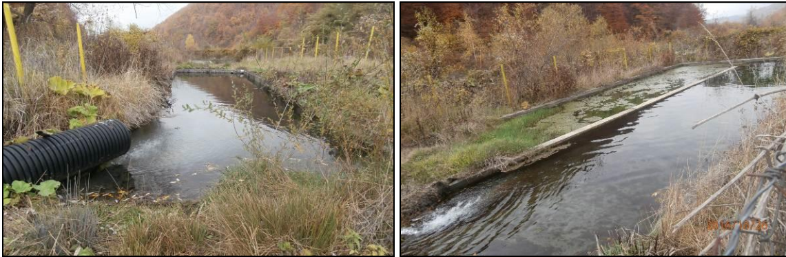
Слика 14 Прв и втор таложник на отпадни води од хидројаловиште
