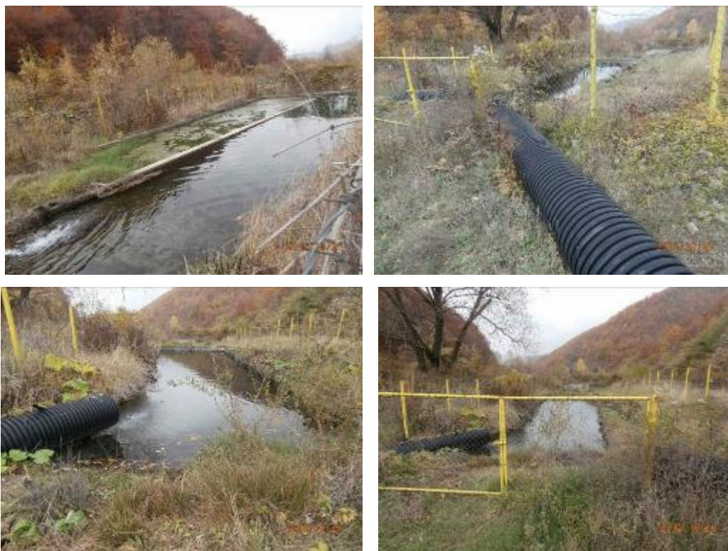
Слика 75 Колектор за одведување на избистрените води во таложниците
