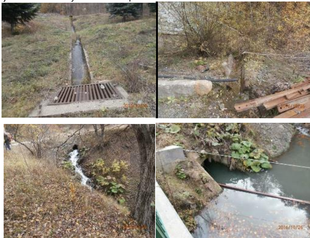
Слика 64 Собирање на атмосферските води и нивно испуштање во Тораничка Река
