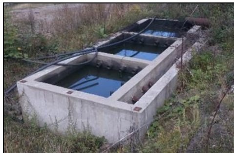
Слика 9 Маслофаќач за третман на атмосферските води од платото пред машинската зграда
