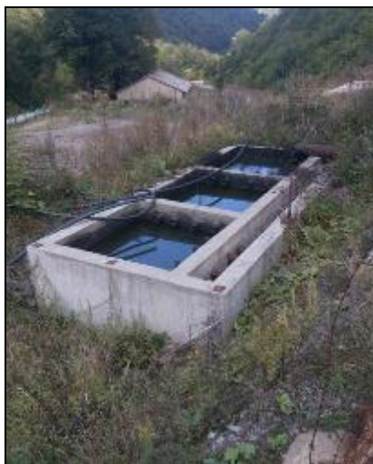
Слика 63 Маслофаќач за третман на атмосферските води од платото пред машинската зграда
