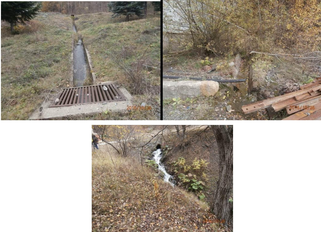
Слика 11 Собирање на атмосферските води и нивно испуштање во Тораничка Река
