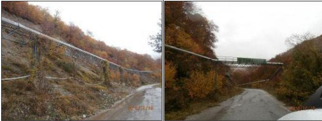
Слика 66 Дел од надземниот пулповод
