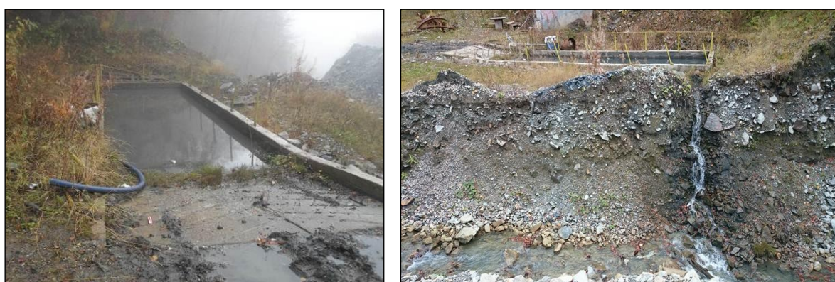
Слика 5 Таложник за јамска вода (поткоп II) и испуст во Тораничка Река
