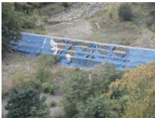
Слика 72 Потпорен ѕид со габиони
