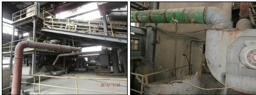
Слика 11 Системи за отпрашување во погонот за дробење и сееење
