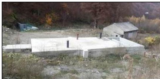
Слика 8 Пречистителната станица за третман на санитарни отпадни води со Емшеров бунар
