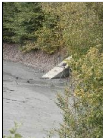
Слика 74 Стар бетонски преливен колектор
