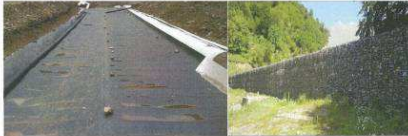
Сл. 10. Дренажен геокмпозит-дренажа со габионски ѕид
