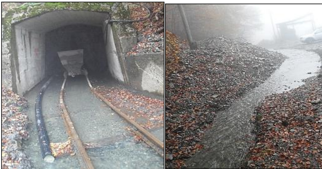
Слика 22 Испуст на јамски води од поткоп I
