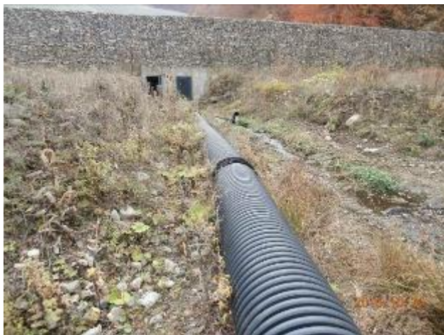
Слика 75 Колектор за одведување на избистрените води во таложниците
