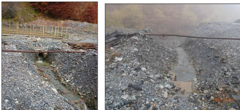
Слика 4 Таложник за јамска вода и испуст во Тораничка Река (поткоп II А)
