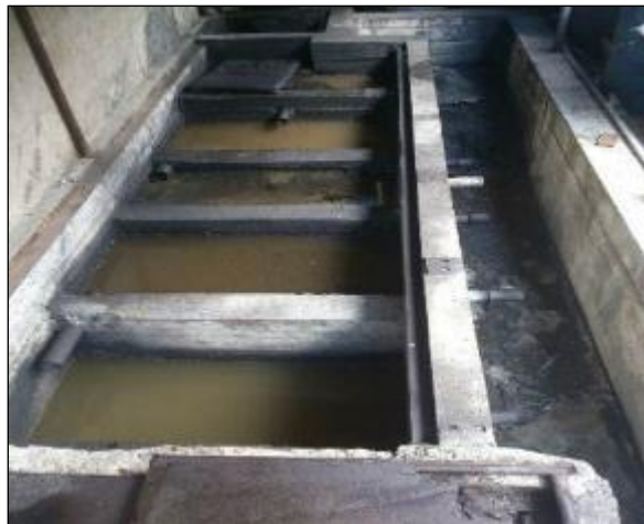
Слика 60 Маслофаќач за третман на отпадните води од перење на возилата
