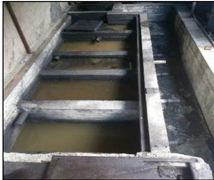
Слика 10 Маслофаќач за третман на отпадните води од перење на возилата
