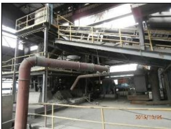
Слика 83 Системи за отпашување во погонот за дробење и сееење
