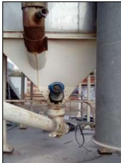
Слика 16. Систем за транспорт на отпрашен филер назад во процесот
