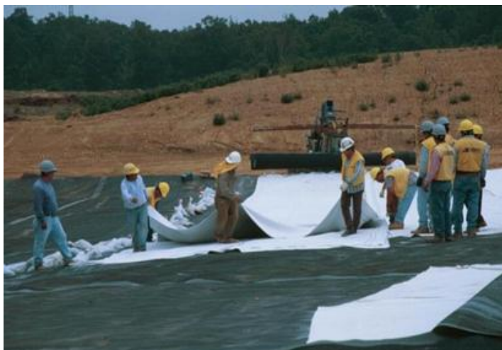
Слика 5: Изградба на подлога на дното
