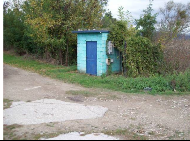
9-1: Куќичка за електронска опрема со мерен праг и шахта за сонди на хидролошка мерна станица на УХМР на река Елешка
