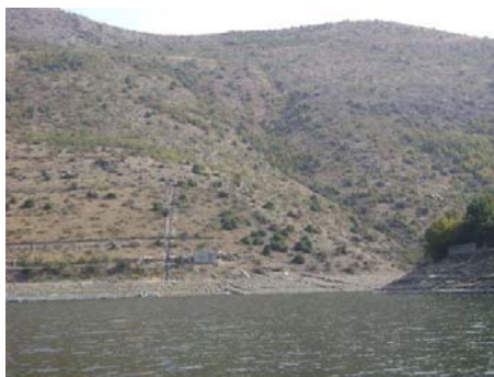
Сл.197 Цефководен систем за извлекување вода од Тиквешкото езеро
