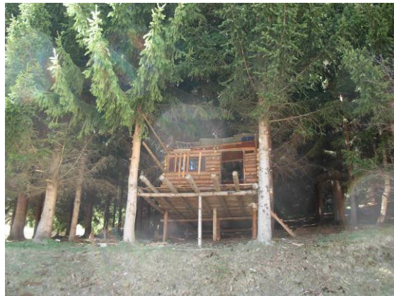
Сл. 48. Бесправен објект кај Три Воде
