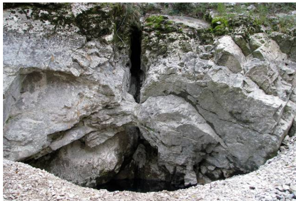
Сл.4 Калцитски мермери на пукнатината на која се јавува изворот Коритиште
