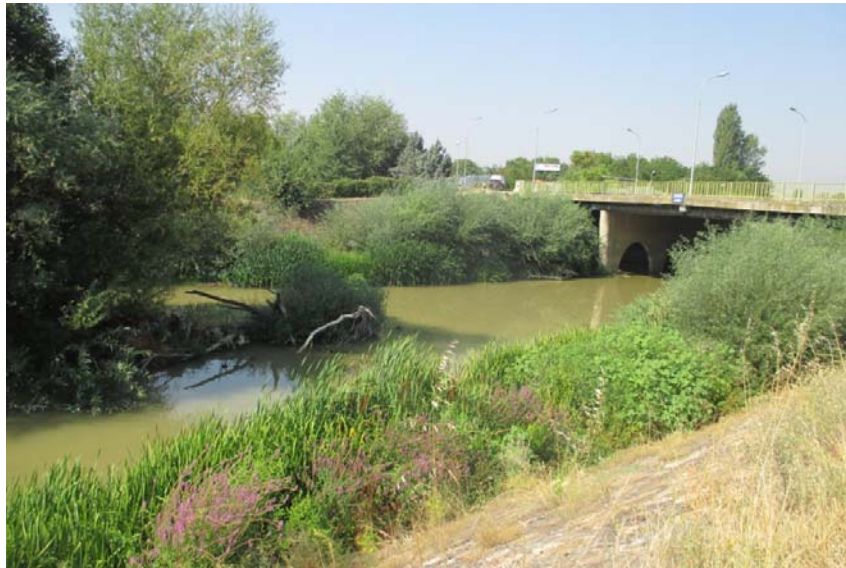
Слика 3. Регулирано корито на река Лепенец возводно од вливот, обраснато со вегетација
