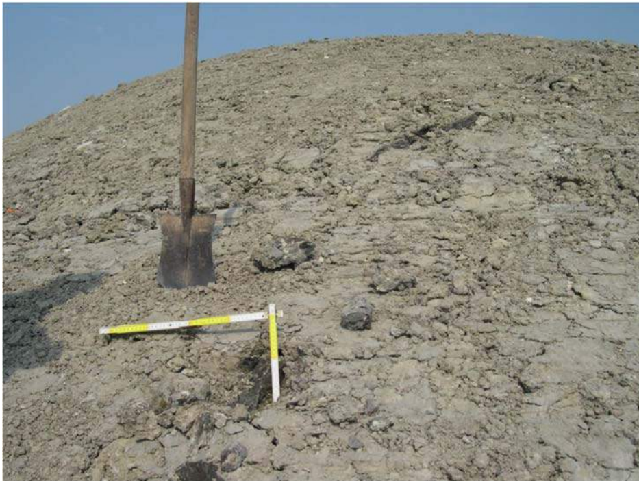
Слика 19 Проверка на дебелината на набиениот слој на глина
