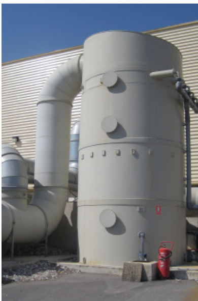
Слика 3-113: а) скрубер и б) биофилтер со материјал за полнење што треба да се инсталира
