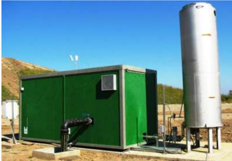
Слика 3-64: Пример на постројка за третман на гас на депонија
