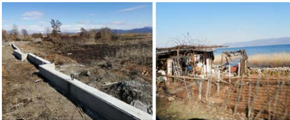
Fotografia 26. Murrë prej betoni në rripin Strugë – Kalishtë dhe shtëpizë montuese Radozhdë
