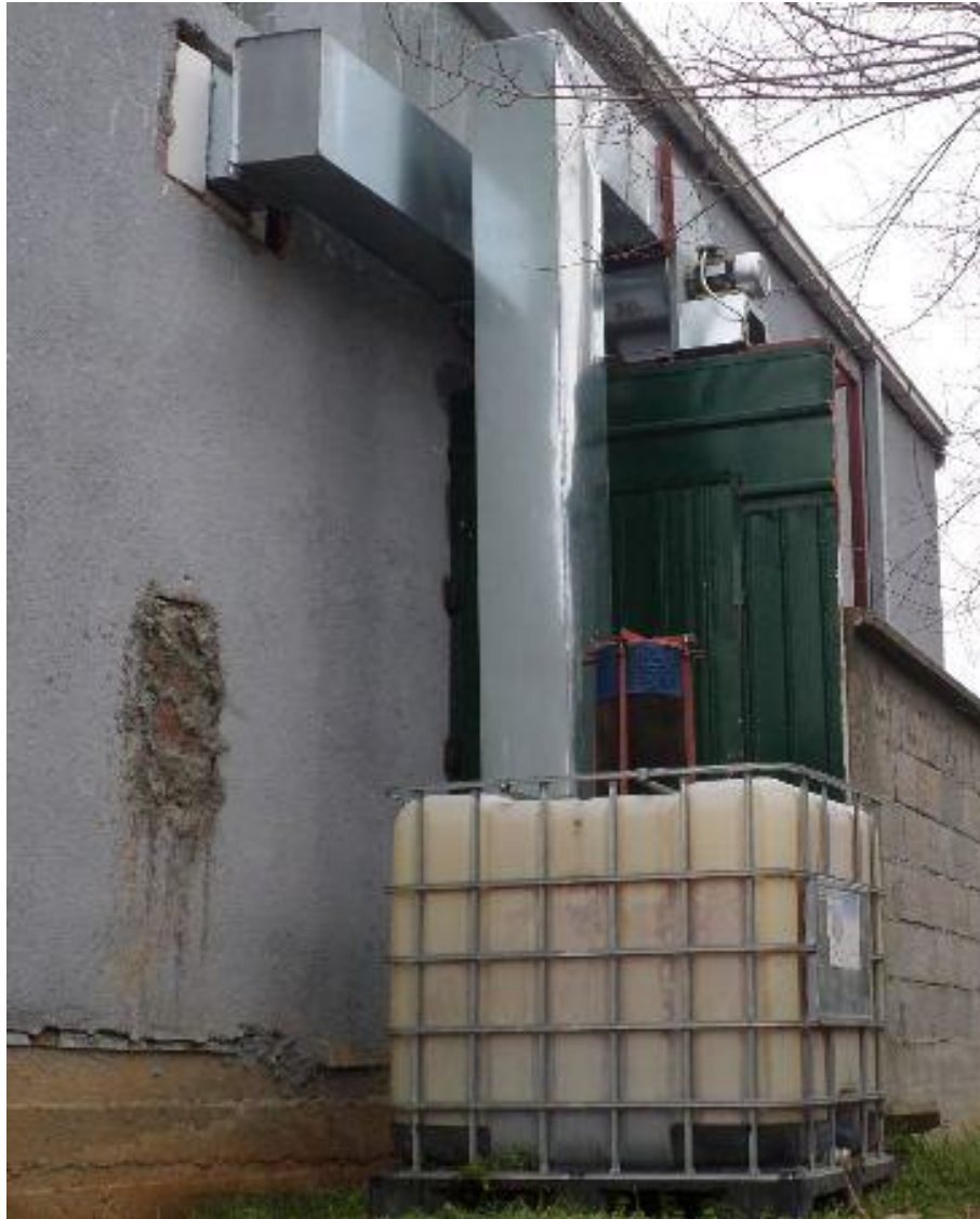
Слика бр.1 Вентилационен испуст
