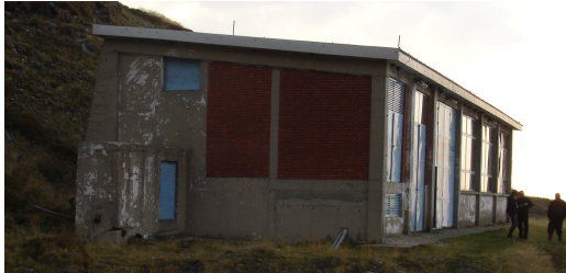
Si i ka br.4. Ventilatorska stanica
