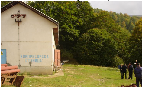
Slika br.2. Kompresorska stanica
