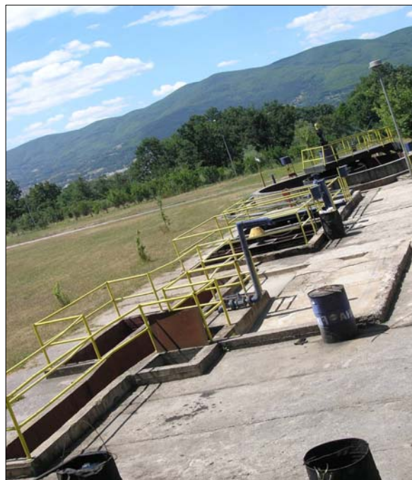
Сл.бр.10 Пескофаќач, неутрализатор и коагулатор
