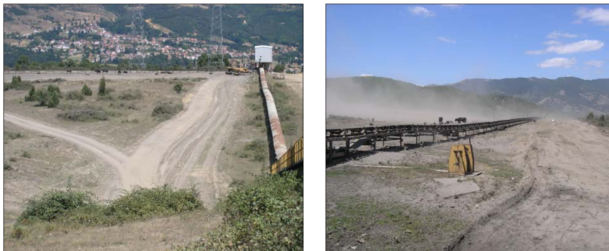
Сл. бр.14 и сл. бр.15 Лентест транспортер за одлагање на електрофилтерската пепел
