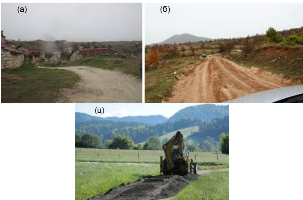
Слика 19: (а) Макадамски пат до село Бешиште, (б) макадамски пат до село Полчиште, (ц) пример за санирање на макадамски пат за обезбедување на непречен сообраќај
