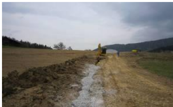
Слика 15: Дренирање за да се спречи собирање на дождовна вода
