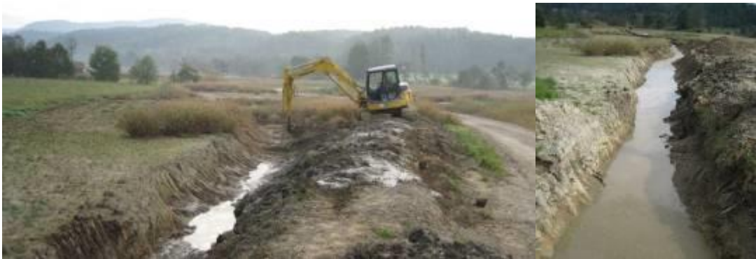
Слика 18: Машинско одржување на каналот за одвод на вода при санациски работи
