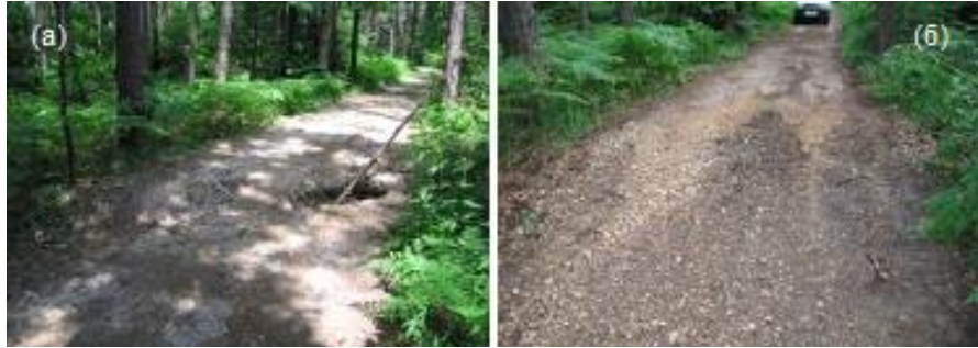
Слика 13: (а) Помали пукнатини на патот, (б) saniран пат
