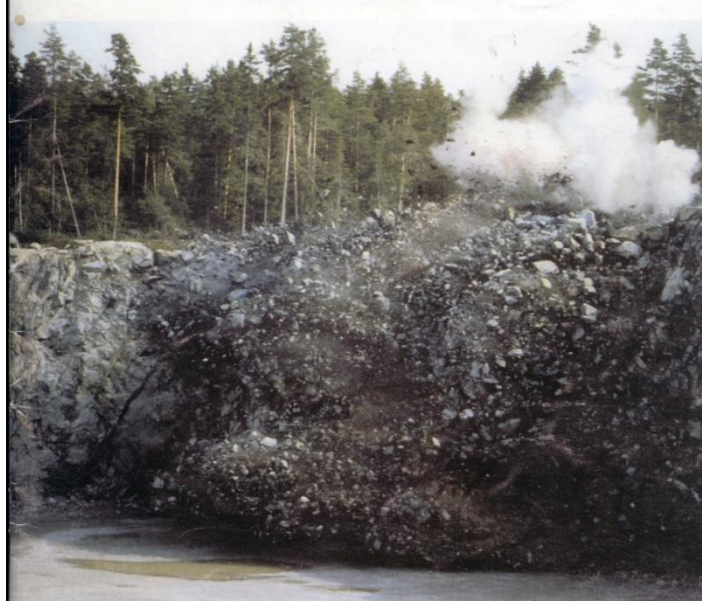
Слика 76 Фотографија направена при минирање со NONEL-систем
