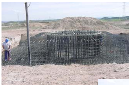
Слика: Изведба на фундамент
