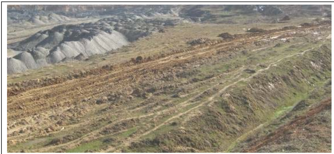
Слика бр.29: Дел од пристапен пат (периферен) и обиколен одводен канал
