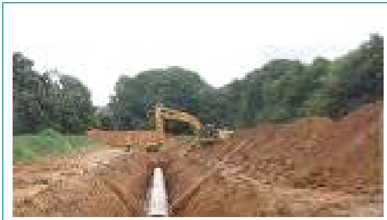
Слика бр.10: Затрпување на ровот со ископаниот материјал
