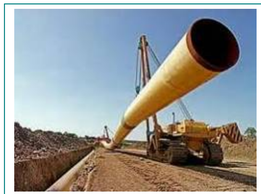
Слики бр.7, 8 и 9: Дел од постапката за изведба на гасовод (спуштање и полагање на цевното црево)
