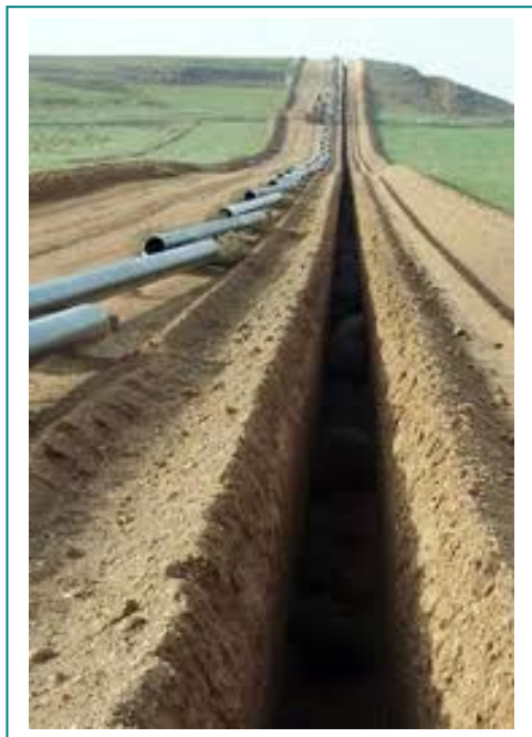
Слики бр.7, 8 и 9: Дел од постапката за изведба на гасовод (спуштање и полагање на цевното црево)
