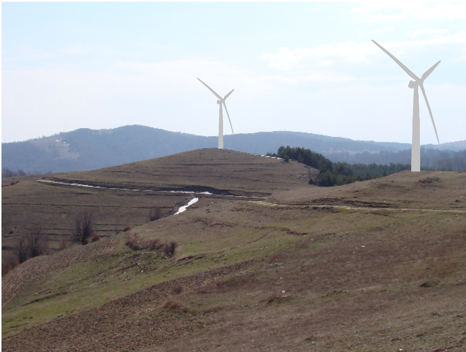
Монтажа: Поглед кон турбинска секција на локалитет Војнова Чука
