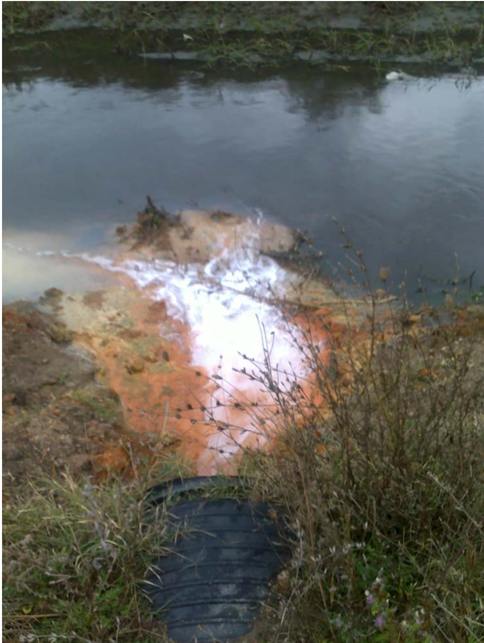
Слика бр.14 Влез на отпадните води во V канал од DZ 1
