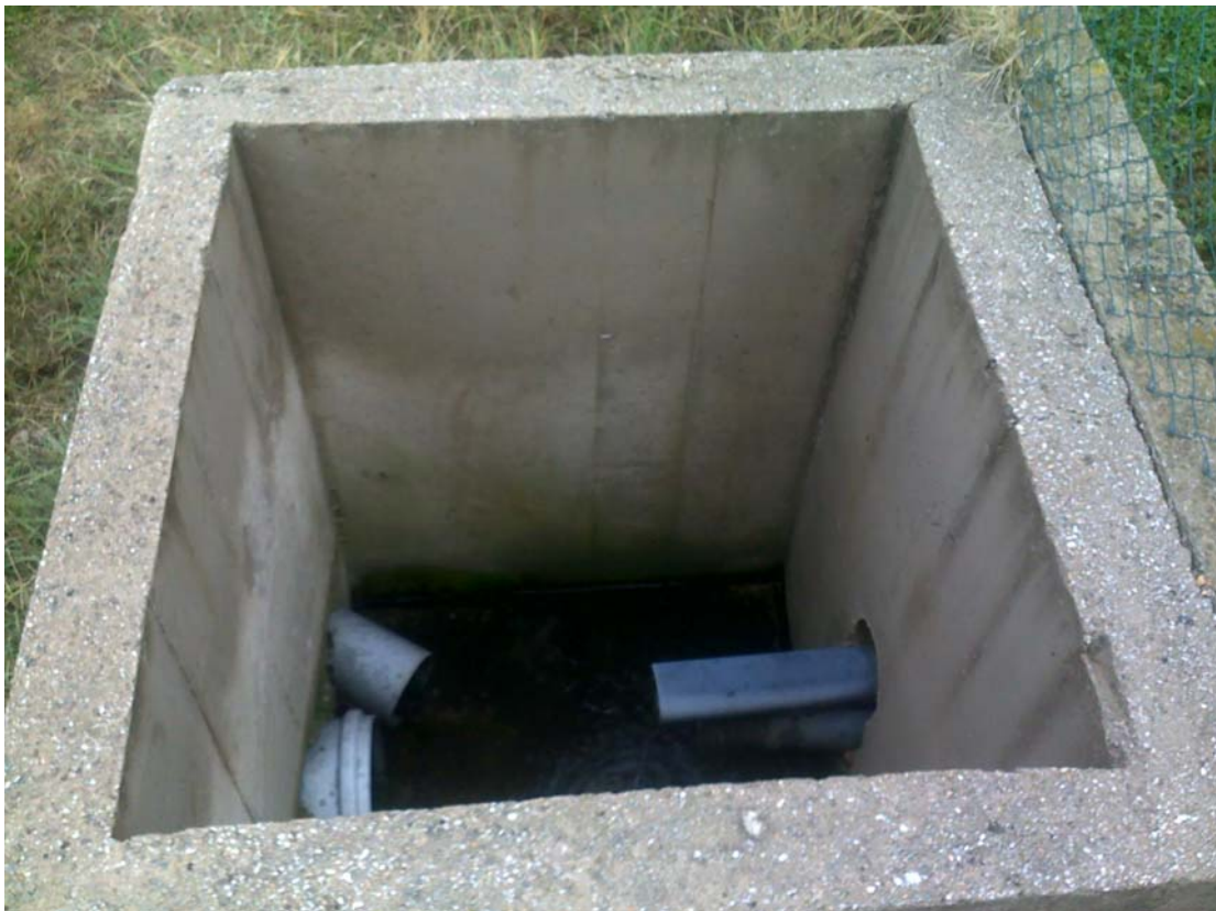
Слика бр. 13 Шахта за санитарни отпадни води
