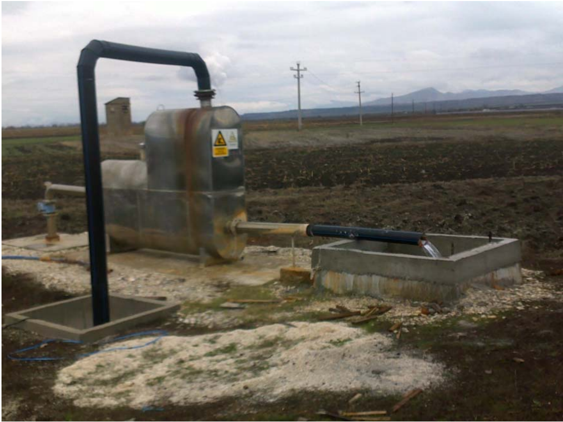
Слика бр.8 Извирање, сепарирање на суров гас од вода-DZ 4
