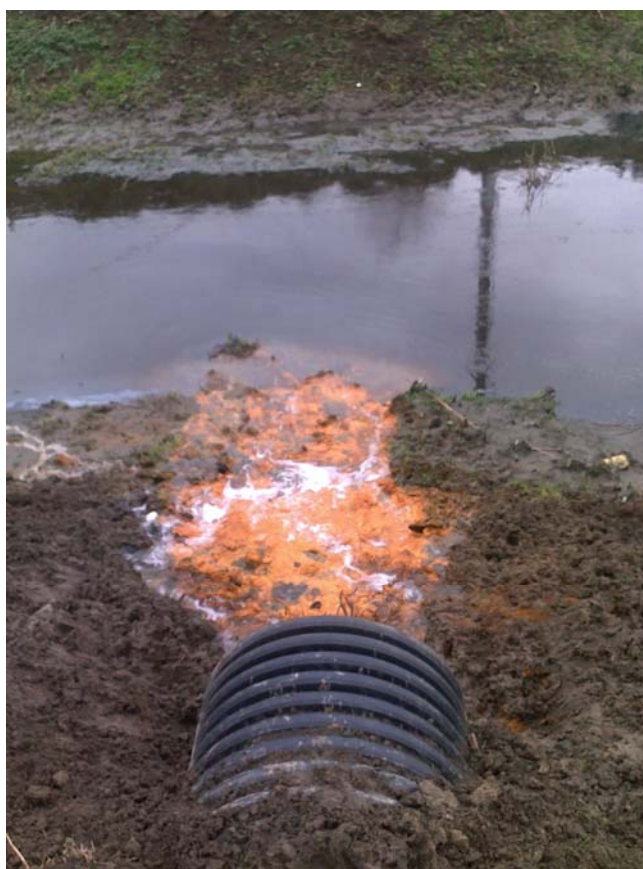
Слика бр.12 Влез на отпадните води во V канал од DZ 4
