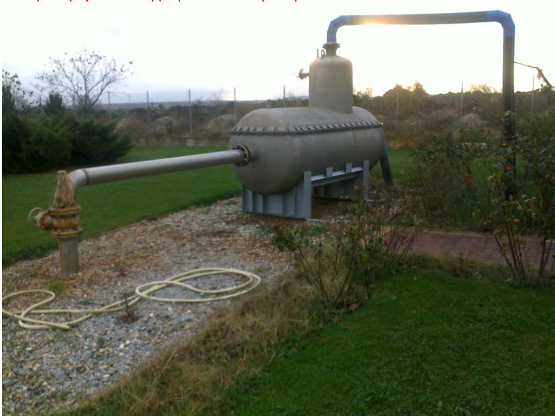
Слика бр.7 Извирание, сепарирање на суров гас од вода-DZ 3
