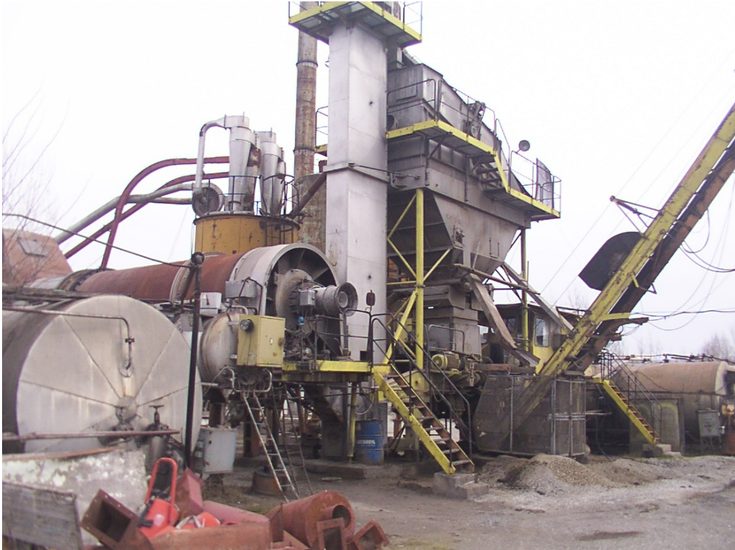
Slika br.1: Asfaltna baza Rosoman
