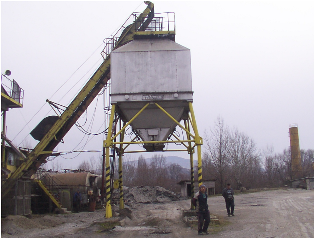
Slika br.3: Silos za gotova asfaltna mešavina
