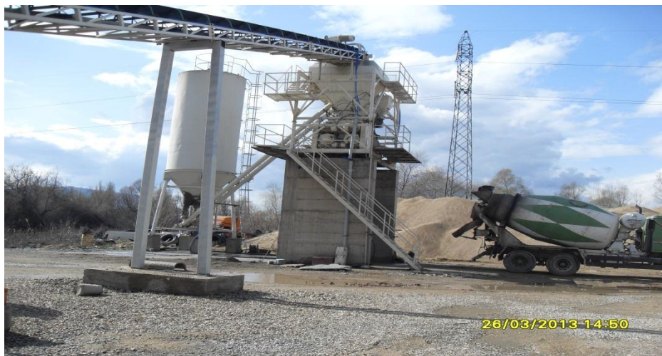
ДЕЛ ОД БЕТОНСКА БАЗА
