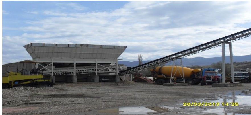
ДЕЛ ОД БЕТОНСКА БАЗА
