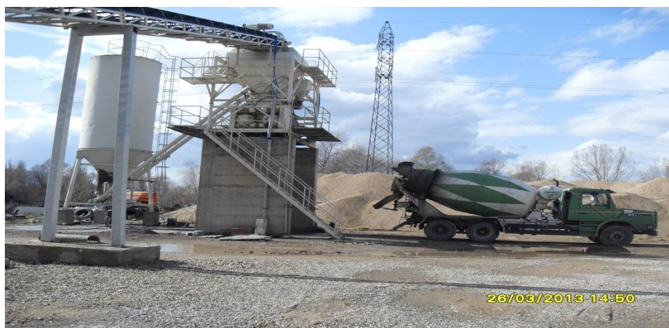
ДЕЛ ОД БЕТОНСКА БАЗА
