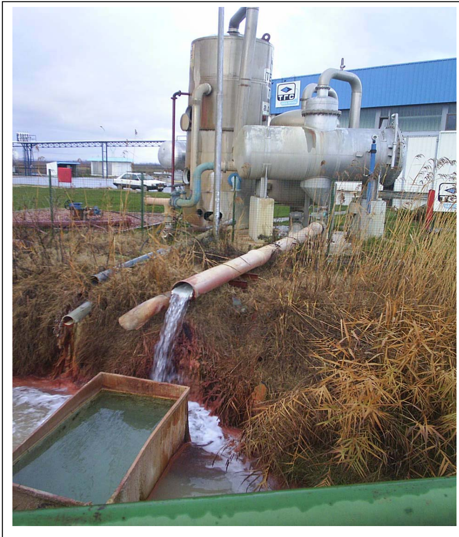
Слика бр. VI-3: Испуст SW 1
