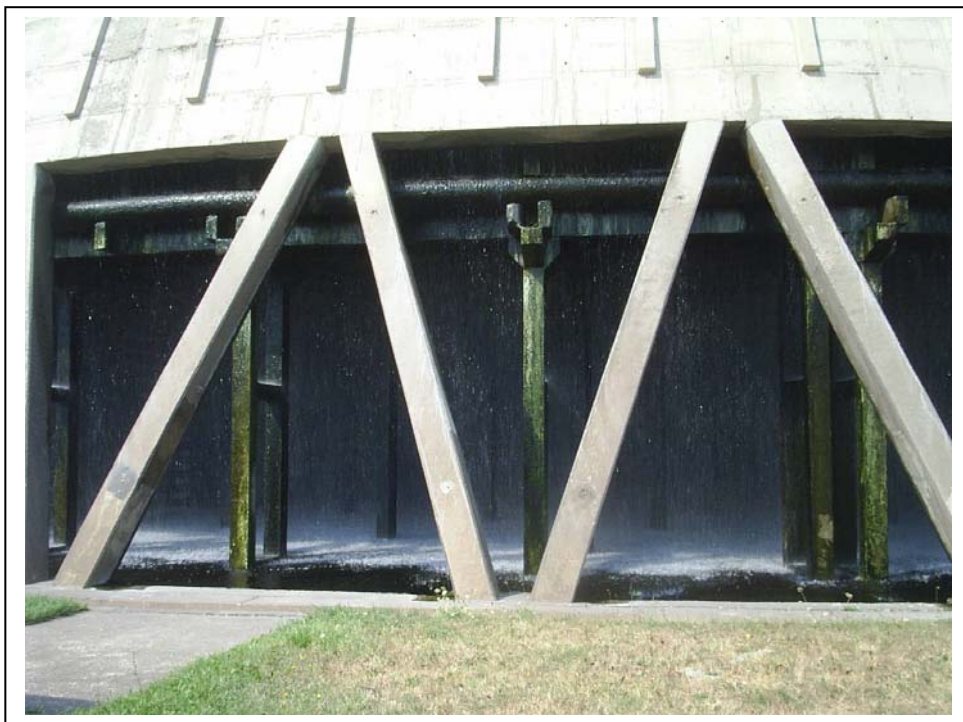
Слика бр. II-32: Водособирен базен на ладилната кула
