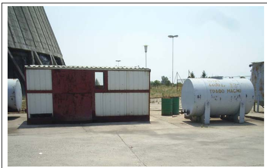
Слика бр. V-9: Опрема за пречистување на трафо масло
