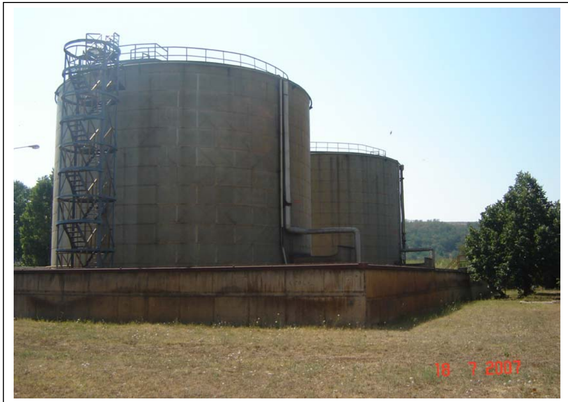
Слика бр. V-14: Резервоари за мазут за котлите од Блок 1, 2 и 3
