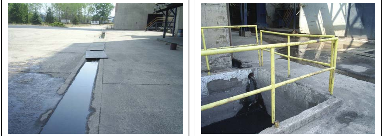
Слика бр. VI-10 и бр. VI-11: Дел од атмосферската канализација и таложник
