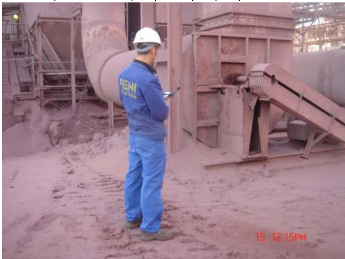
Слика 2 Мерење на вентилатор на вреќасти филтер на дробење
