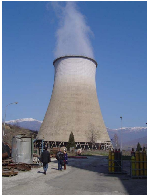
Слика 12: Ладилни кули со природна циркулација во ТЕЦ Осломеј
