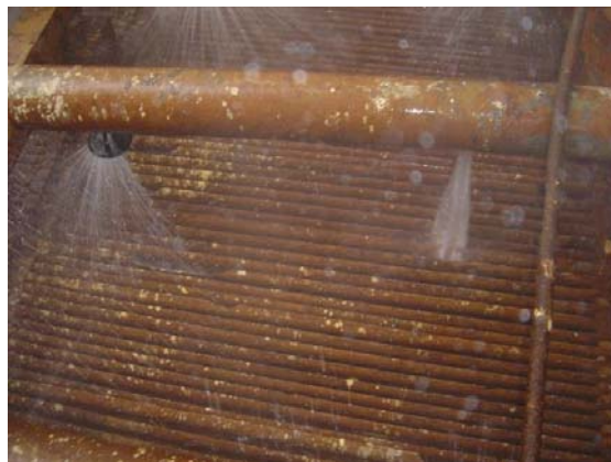
Слика 13: Систем за ладење во ладилната кула (цевководи, прскалки, исполна)
