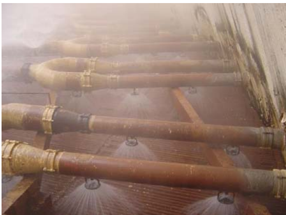
Слика 13: Систем за ладење во ладилната кула (цевководи, прскалки, исполна)
