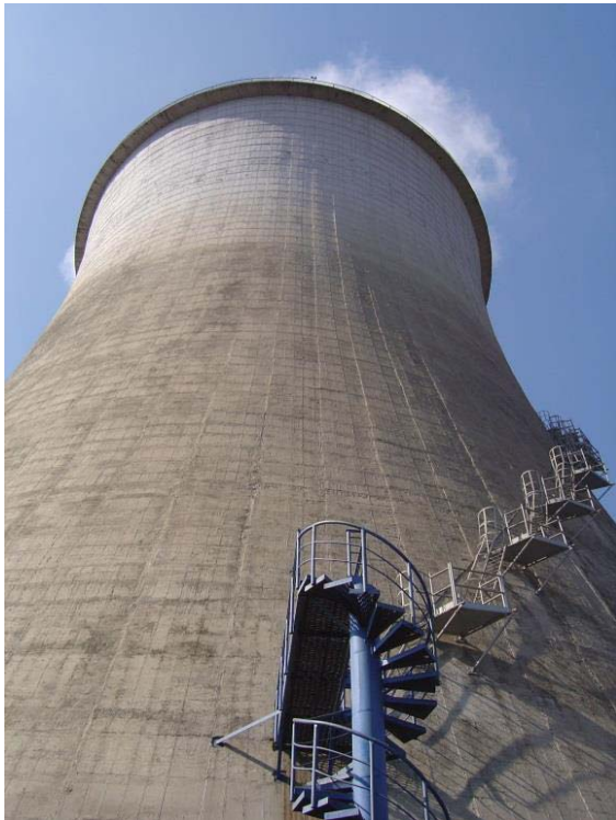
Слика 12: Ладилни кули со природна циркулација во ТЕЦ Осломеј
