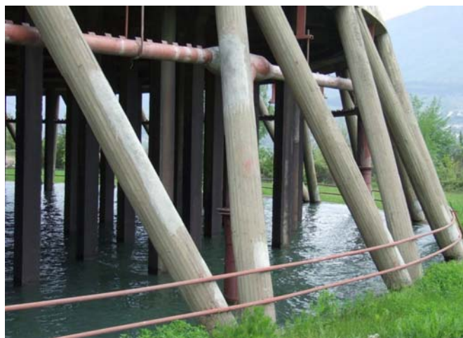
Слика 15: Прстен – цевковод поради замрзнување
